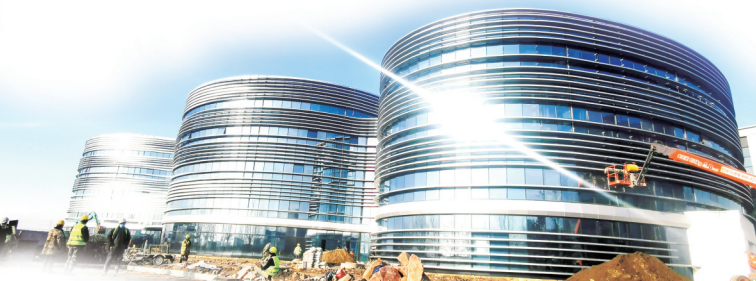
敦尔佳·北方生物美谷产业基地项目现场。
