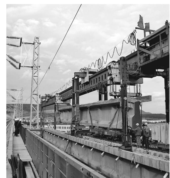
近日,随着一片长32.6米、重139.2吨的T型梁稳稳落在桥墩上,现场瞬间响起了震耳欲聋的鞭炮声,此举标志着牡绥铁路扩能改造工程二标段小绥芬河单线特大桥架梁施工全面展开。
