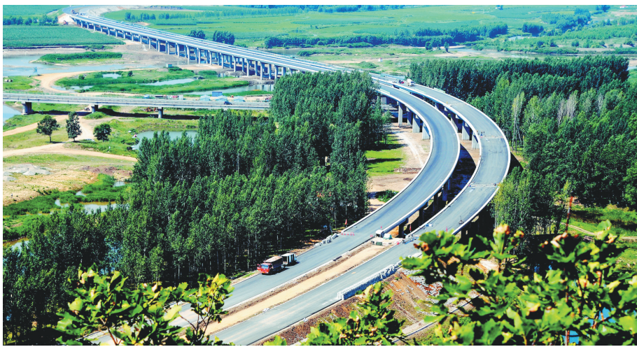
在牡丹江与海林之间,一条银色丝带跨河、绕岭,蜿蜒在丛山峻岭间,气势宏伟,这就是即将通车的牡海城际公路。公路建成后,从海林市到牡丹江市的车程仅需10分钟,有利于加快牡丹江、海林城市一体化进程。图为已经完成主体和桥面工程的海浪河特大桥。张春祥 本报记者 邵国良摄
