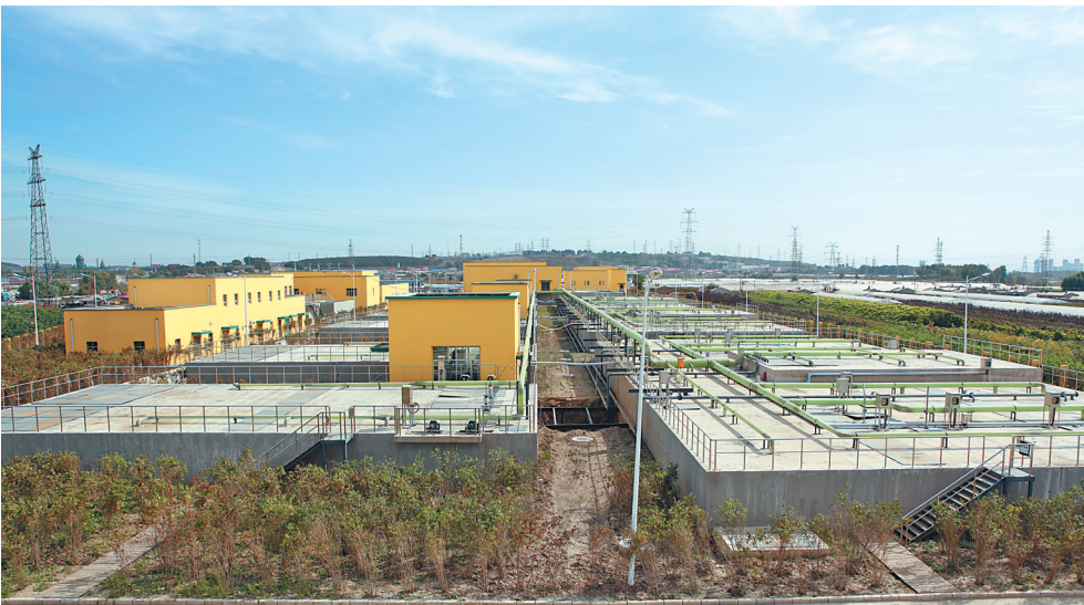
团结镇污水处理厂悬浮澄清池。
