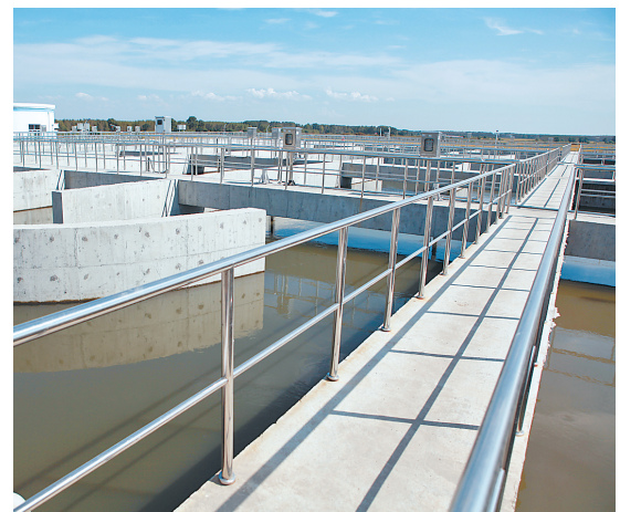
成高子镇污水处理厂生化池。
