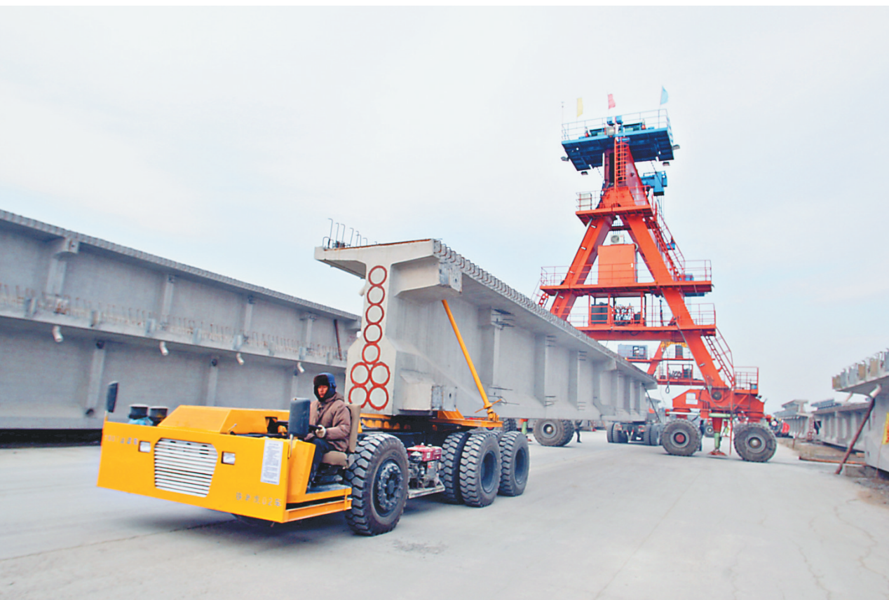
施工现场在进行运钢梁工作。
