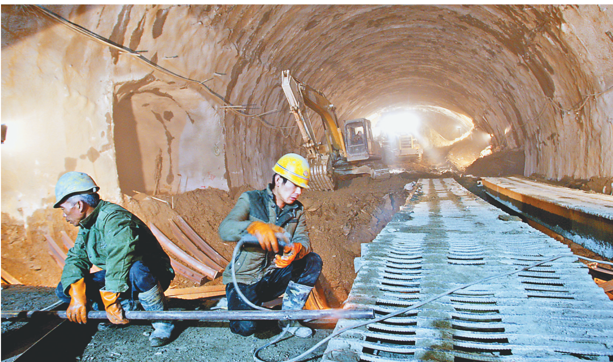
马鞍山隧道施工现场。
