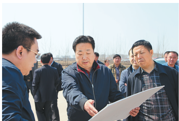
封殿辉在检查保障房建设情况。本报记者 潘宏宇摄
