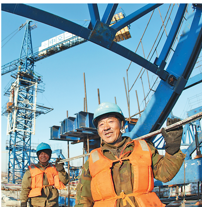
木兰大桥建设现场。
