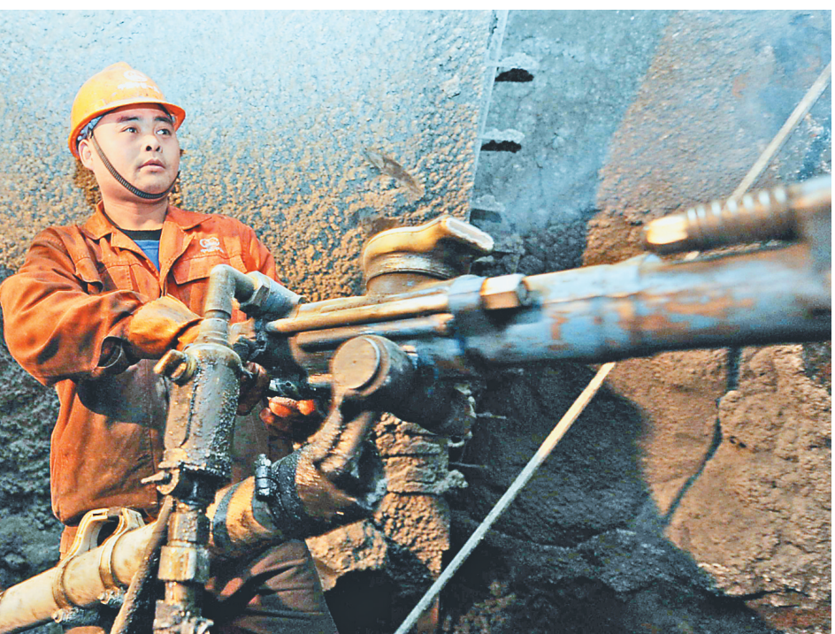
上图为中铁一局的施工人员正在镇北隧道内的掌子面上进行打孔作业。
