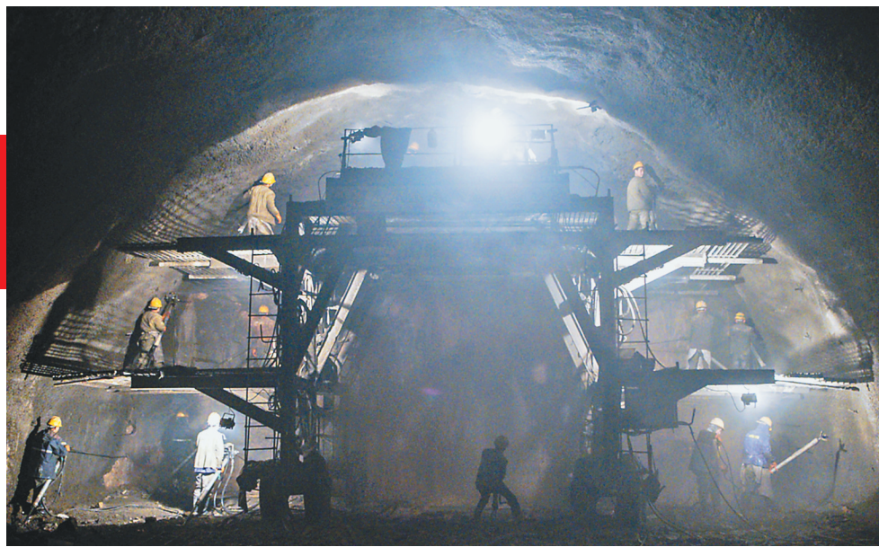
寒冬中施工的虎峰岭隧道。
