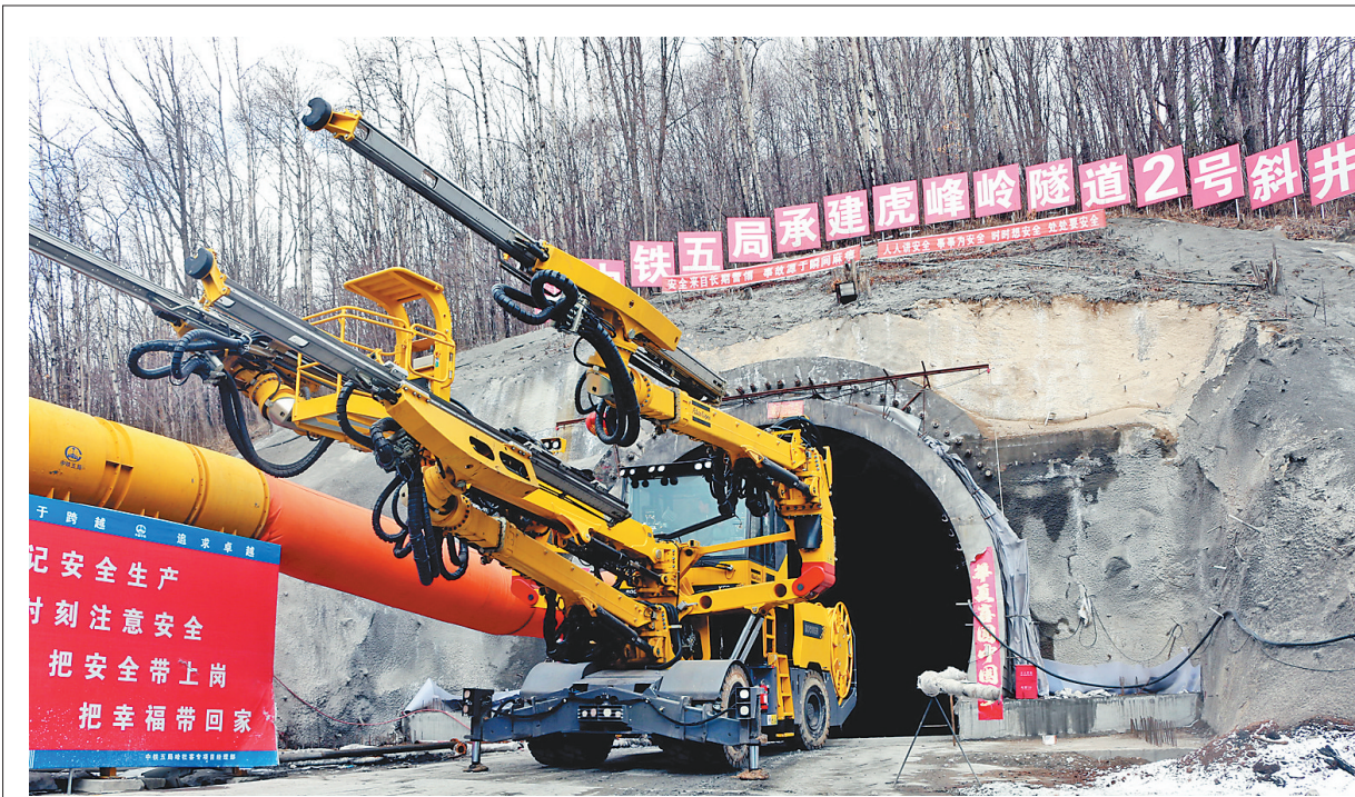
近日,一台有着“变形金刚”外形的前臂凿岩台车驶入哈牡客专第一隧道虎峰岭隧道2号斜井投入隧道施工。据了解,这台国际最先进隧道开挖设备的投用,拉开了虎峰岭隧道生产全面机械化的序幕,使隧道施工安全质量控制、工序衔接、施工进度掌握都提升了一个新的水平。
