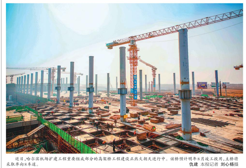
近日,哈尔滨机场扩建工程重要组成部分的高架桥工程建设正热火朝天进行中。该桥预计明年8月竣工投用,主桥将采取单箱8车道。
