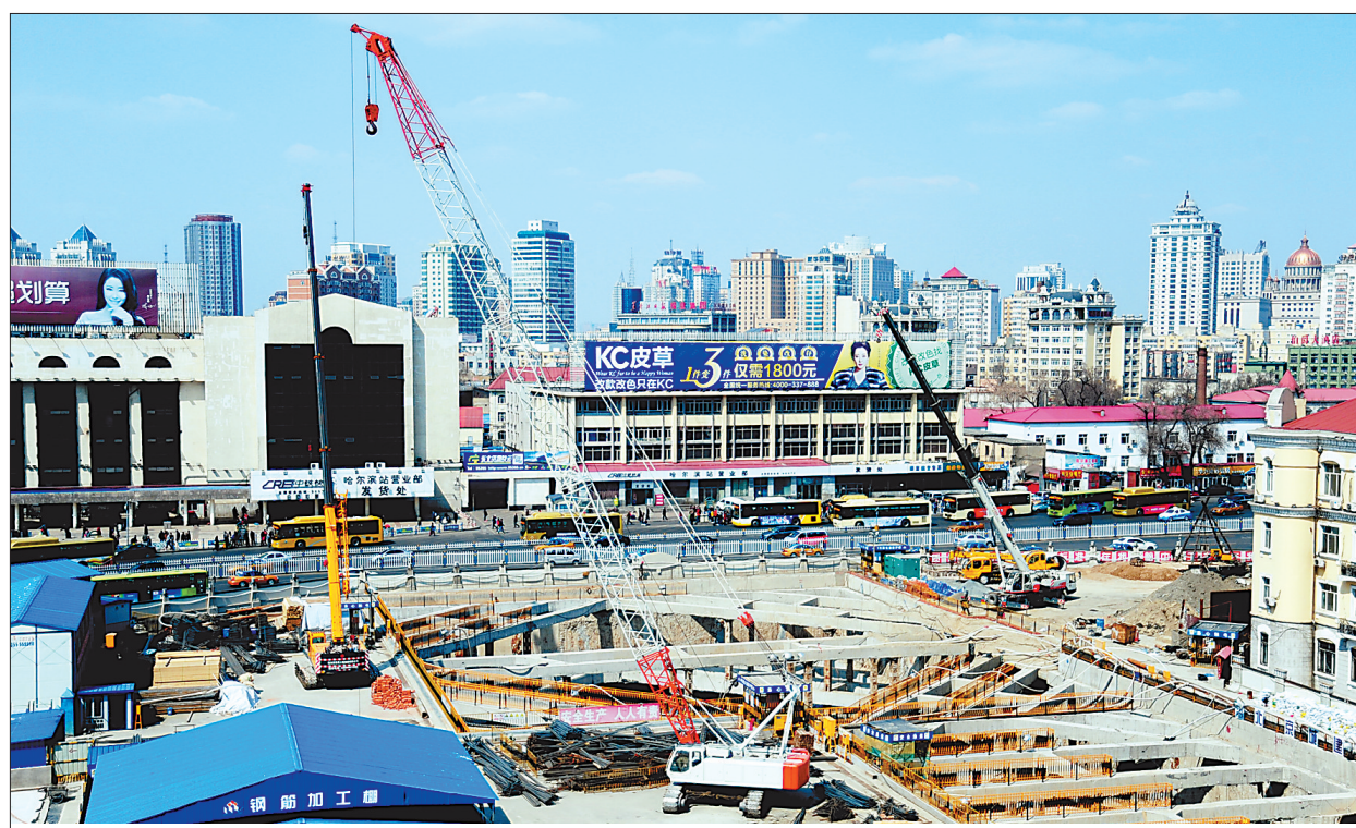
在哈尔滨火车站地铁2号线一期工程现场,建设者们正绑扎钢筋、进行焊接作业(上图)。与此同时,在哈尔滨市平房区的地铁1号线三期工程镜泊路站至新疆大街站施工区间,大型盾构机正在掘进隧道。直径为6.25米的盾构机,每天可掘进10米,实现“一次成洞”。这是目前地铁暗挖施工中最先进的施工工法。据了解,省城地铁工程开工一个月来,各个工程段的建设大军昼夜奋战在天上地下,克服困难,全力以赴,施工进度喜人。本报记者 王振良 高明摄
