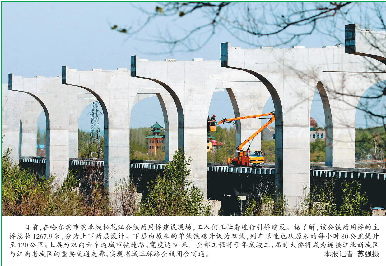
日前,在哈尔滨市滨北线松花江公铁两用桥建设现场,工人们正在进行引桥建设。据了解,该公铁两用桥的主桥总长1267.9米,分为上下两层设计。下层由原来的单线铁路升级为双线,列车限速也从原来的每小时80公里提升至120公里;上层为双向六车道城市快速路,宽度达30米。全部工程将于年底竣工,届时大桥将成为连接江北新城区与江南老城区的重要交通走廊,实现省城三环路全线贯通。
