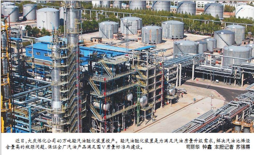
近日,大庆炼化公司40万吨轻汽油催化装置投产。轻汽油催化装置是为满足汽油质量升级需求,解决汽油池烯烃含量高的瓶颈问题,保证全厂汽油产品满足国V质量标准而建设。
