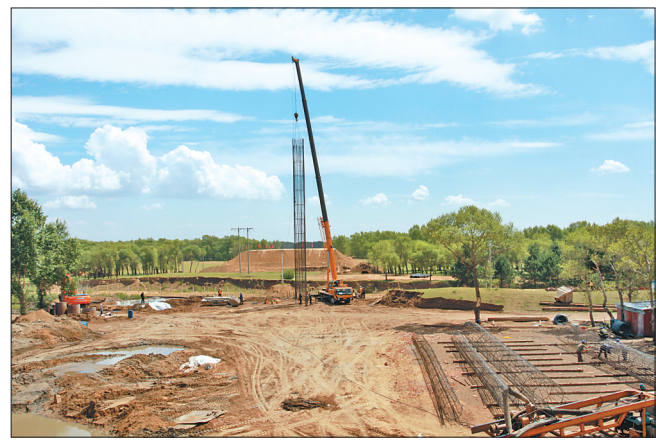
省道绥化至江桥(黑蒙界)公路江桥至黑蒙界公路建设项目,是打通黑龙江和内蒙古之间断头路的重点项目,项目全长9.639公里。目前,一座跨越铁路大桥和二座中桥正在施工,全线箱涵施工全面展开。图为施工现场。
