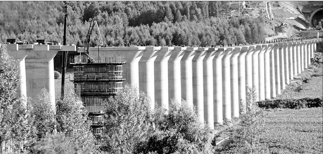
近日,在哈佳高铁依兰段施工现场,工人正进行桥墩浇筑和桥梁架设等工程。据了解,该高速铁路是哈尔滨至佳木斯的气化双线铁路,线路全长343公里,设计时速200公里,预计2019年完工。
