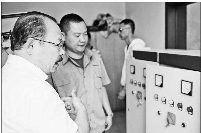
自来水公司专家和工作人员正在检查泵房变频设备。 本报记者 刘晓云摄
