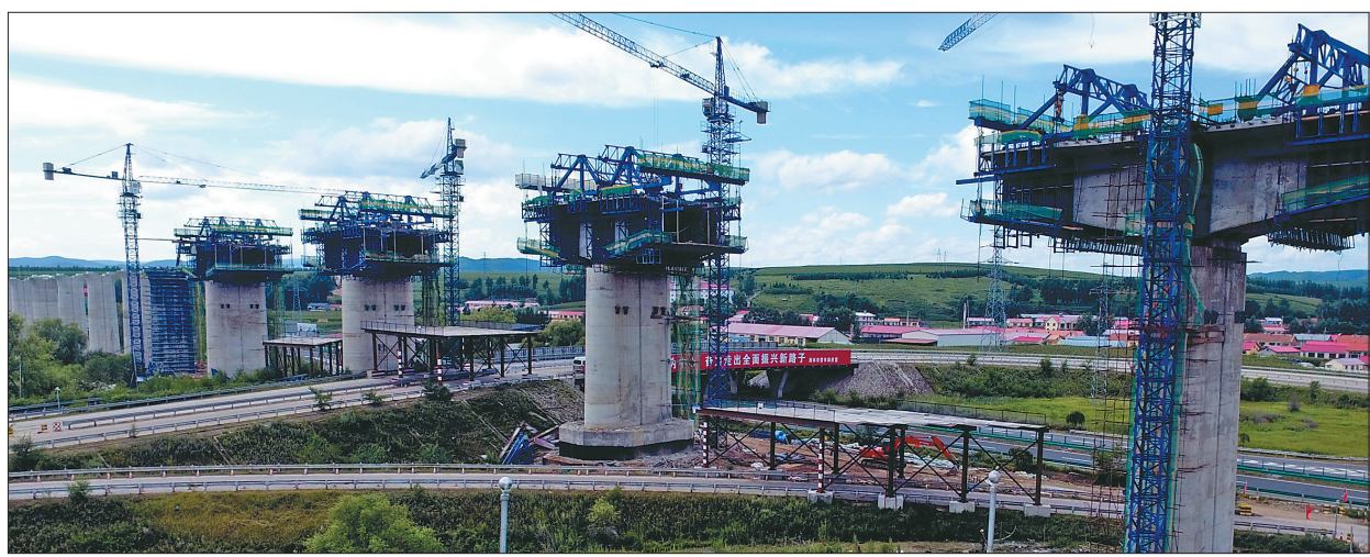
位于海林市的斗银河特大桥是哈牡客专项目的控制性工程。目前随着主线桥墩基本完工,标志大桥建设进入新阶段。张春祥 本报记者 邵国良摄
