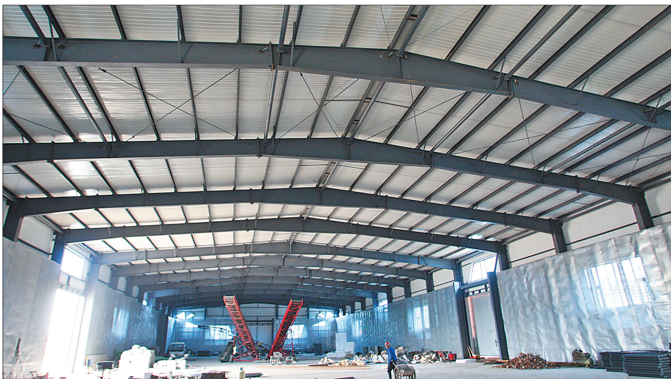
中鼎跨境农业加工项目建设现场。
