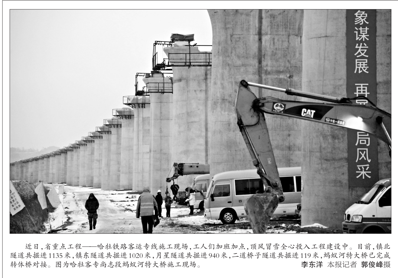
近日,省重点工程——哈牡铁路客运专线施工现场,工人们加班加点,顶风冒雪全身心投入工程建设中。目前,镇北隧道共掘进1135米,镇东隧道共掘进1020米,月星隧道共掘进940米,二道桥子隧道共掘进119米,蚂蚁河特大桥已完成转体桥对接。图为哈牡客专尚志段蚂蚁河特大桥施工现场。 李东洋 本报记者 郭俊峰摄
