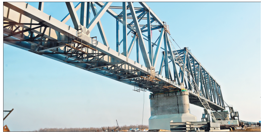
正在建设中的同江铁路大桥
