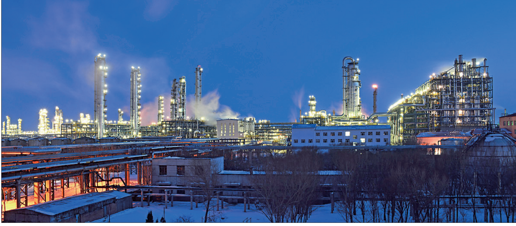
中石油120万吨乙烯项目。
