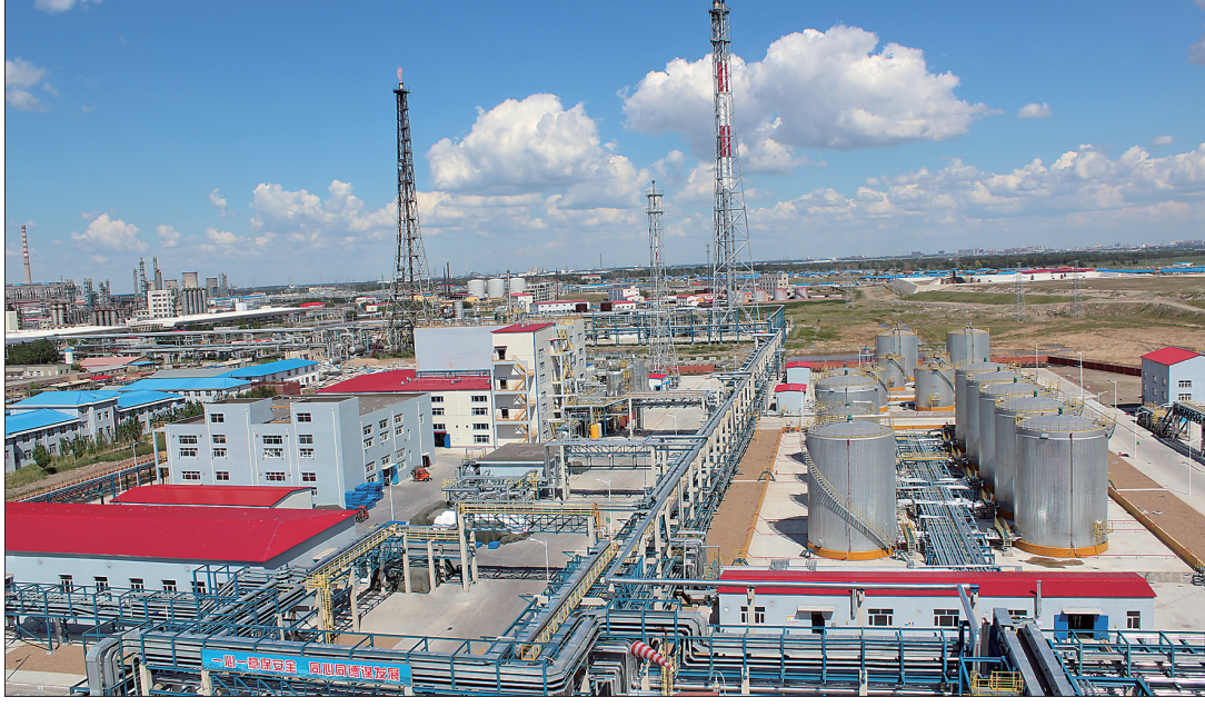
大庆三聚能源净化有限公司新戊二醇项目厂区。
