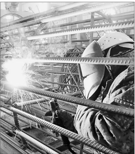
近日,黑河——布拉戈维申斯克黑龙江(阿穆尔河)大桥项目现场一派繁忙的施工景象。大桥施工建设者正在积极做好扩头钻孔桩的施工作业以及砂砾石备料、焊制护筒、钢筋笼预制等先期工作,保障和推进大桥建设的施工进度。图为施工人员进行钢筋笼预制加工。
