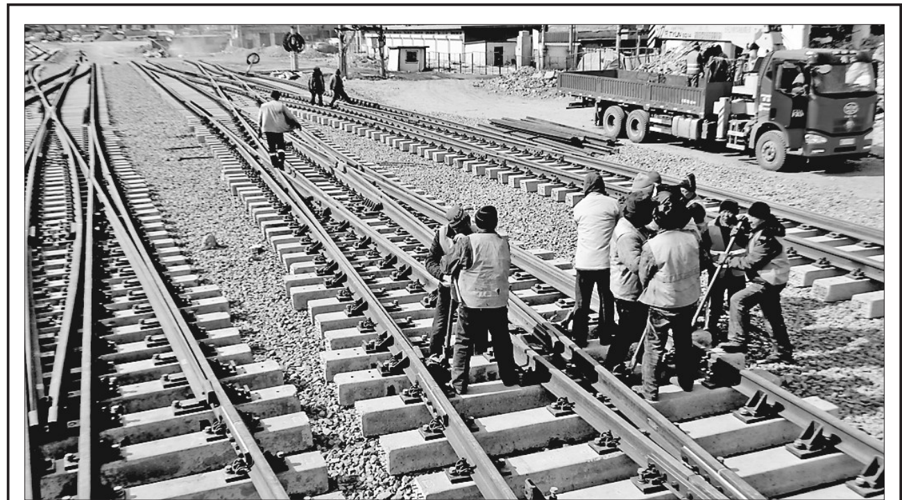
进入3月份以来,随着气温的不断攀升,哈牡客专牡丹江站房站场项目工程复工建设全面展开。站房、站台、站场等工程施工紧张同步进行。据了解,哈牡客专工程2016年3月份开工建设,预计2018年8月末竣工并交付使用。图为哈牡客专牡丹江站房工程现场,施工工人正在进行站台和轨道铺设。
