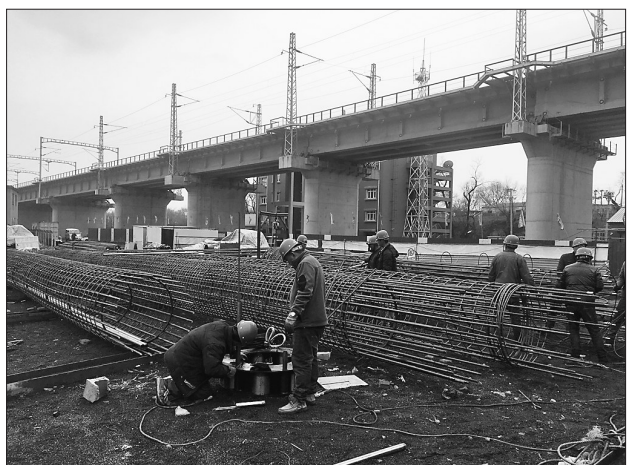
图为松花江公铁两用桥市政桥梁部分施工现场。 本报记者 邢汉夫摄
