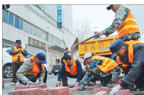
近日,南岗区启动春季道路简易维修工作,设立巡查机动小组加大巡查力度,依托网格化管理机制,做到定点、定位、定街路巡查,一旦发现道路翻浆、破损情况,迅速反馈给春季道路简易维修队,确保及时跟进维修。图为工作人员正在维修破损道路。
