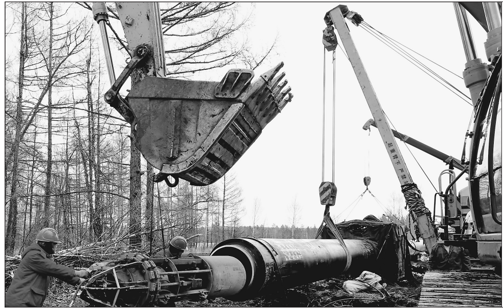
漠河中俄原油管道二 线工程正在繁忙有序的 施工中,工程人员克服了 地形复杂等困难,完成管 线焊接等工程87公里。 据了解,中俄原油管道二 线工程是2016年10月10 日开始施工,起点漠河至 塔河全长100公里,预计 在今年9月30日完工。 闫捍江 本报记者 刘 大泳 邱成祺
