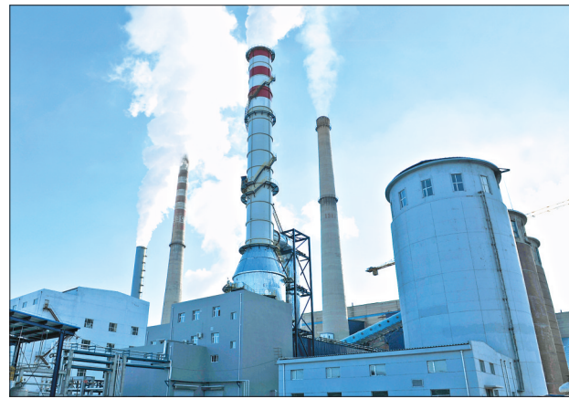
热电厂脱硫装置正式投用。
