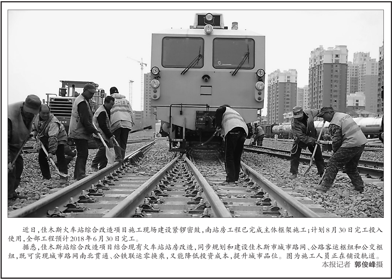
近日,佳木斯火车站综合改造项目建设施工现场紧锣密鼓,南站房工程已完成主体框架施工;计划8月30日完工投入使用,全部工程预计2018年6月30日完工。 据悉,佳木斯站综合改造项目结合现有火车站站房改造,同步规划和建设佳木斯市城市路网、公路客运枢纽和公交枢纽,既可实现城市路网南北贯通、公铁联运零换乘,又能降低投资成本,提升城市品位。图为施工人员在铺设轨道。 本报记者 郭俊峰摄
