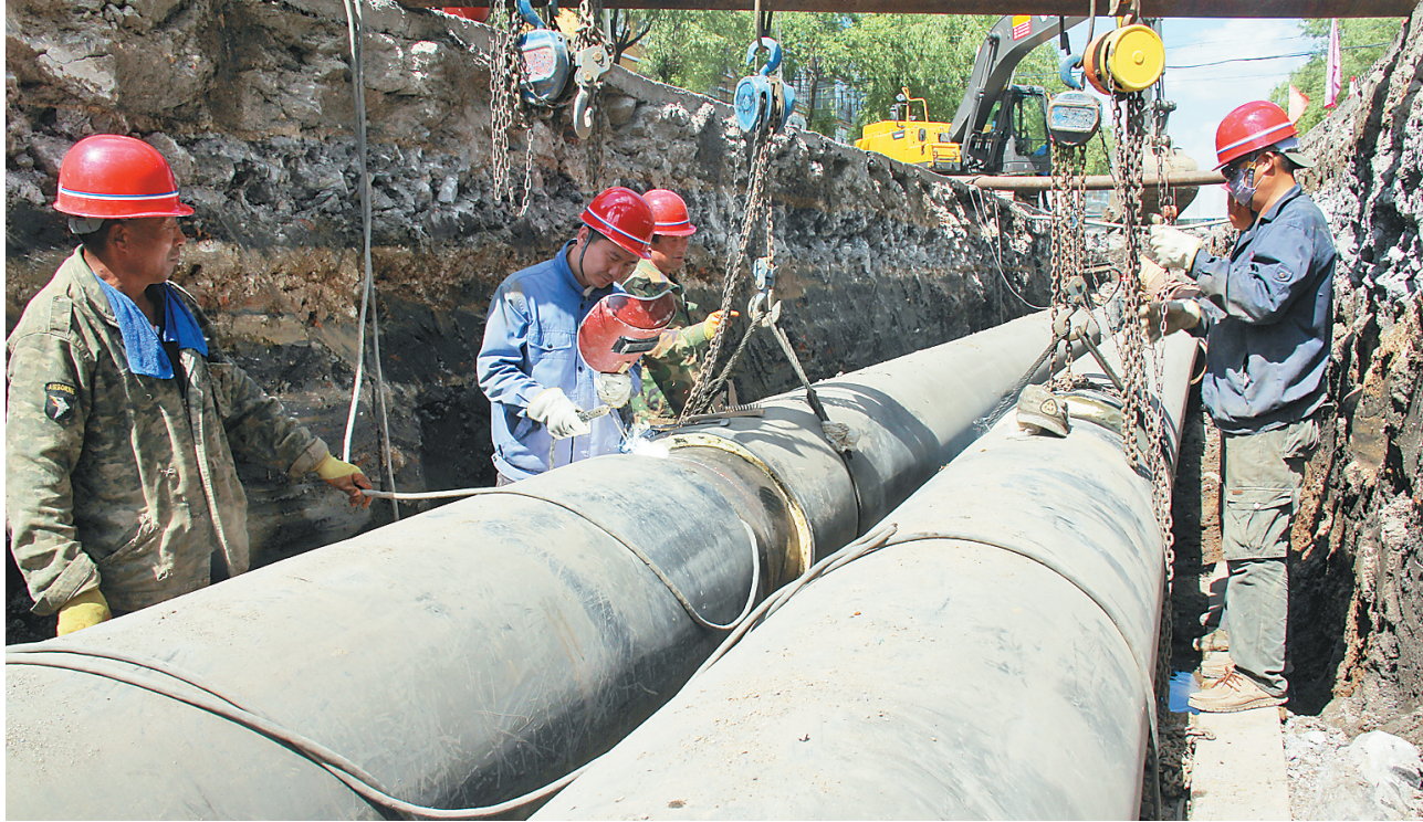
施工人员在连接管径。
