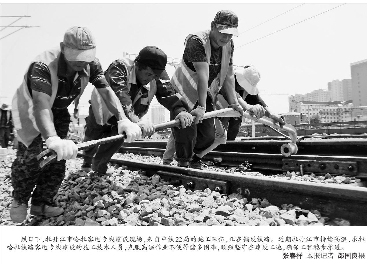
烈日下,牡丹江市哈牡客运专线建设现场,来自中铁22局的施工队伍,正在铺设铁路。近期牡丹江市持续高温,承担哈牡铁路客运专线建设的施工技术人员,克服高温作业不便等诸多困难,顽强坚守在建设工地,确保工程稳步推进。 张春祥 本报记者 邵国良摄
