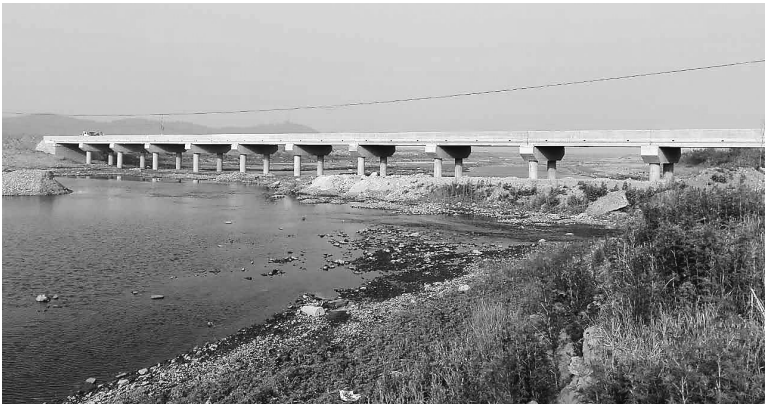
2016年建的钢筋水泥松泉桥
