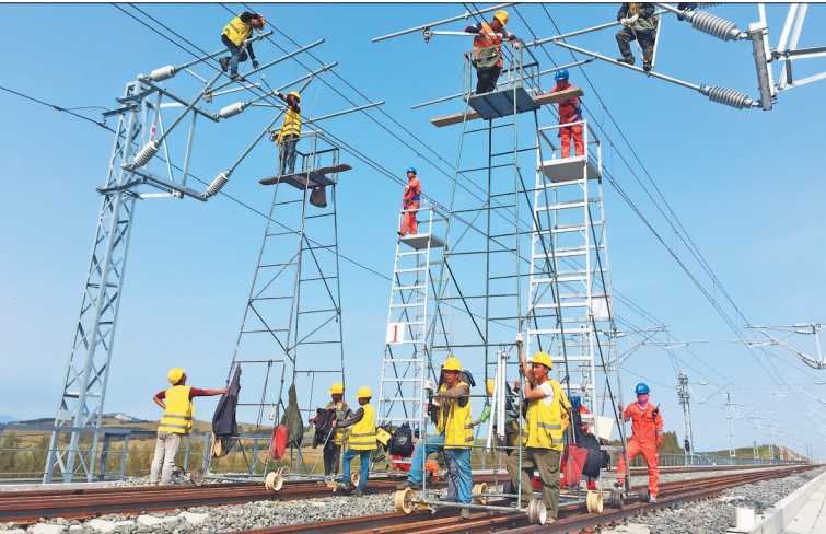
日前,由哈尔滨铁路局牡丹江供电段哈佳筹备车间负责的新建哈佳快速铁路接触网设备静态验收工作,推进至全线重点节点、全线最大跨度依兰境内的牡丹江特大桥,比计划工期提前了6天,为全线如期通车奠定了基础。图为新线牡丹江特大桥接触网设备静态验收现场。
