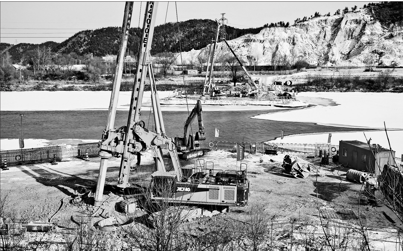
大雪时节,龙江大地已经是天寒地冻,在牡佳客专建设工程牡丹江特大桥建设现场却是机声隆隆,两台旋挖钻机不停地在轮流开挖作业。据了解,由中铁四局集团承建的牡佳客专牡丹江特大桥,桥梁全长6.093公里,桩基1589根,承台175个,挖井基础8个,墩台身173个,连续梁5联,T构梁1联,跨越牡丹江采用连续梁,是本特大桥的控制性工程。今年10月26日,牡佳建设项目一标段首根桩孔桩顺利开工以来,建设者们顶风冒雪,确保了各节点建设任务全力推进。
