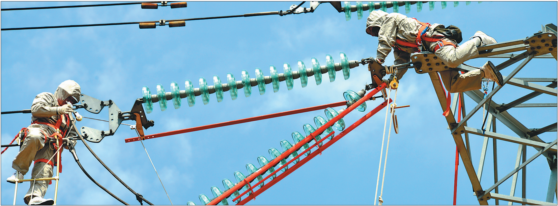
专业人员在高温天气下通过带电作业方式更换绝缘子,以减少停电给客户带来的不便。
