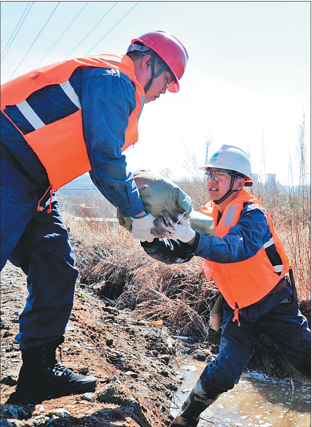
送电专业人员对低洼地段的线杆基础进行加固处理。
