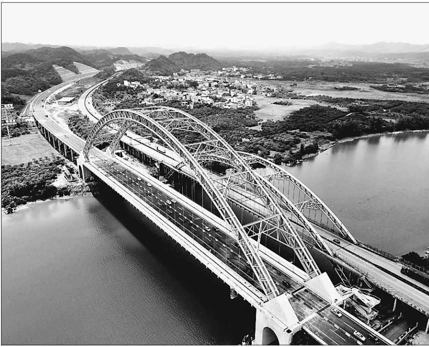
5月1日，车辆在六景都江高速公路特大桥(左)上通过。当日，柳南高速改扩建项目重要控制性工程之一的六景都江特大桥正式通车。六景都江特大桥总长1127米，桥面宽35米，为单向四车道。
