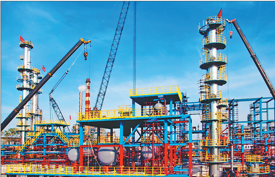
大庆石化炼油结构调整优化和转型升级施工项目现场,工人们正在加紧进行设备安装。该项目主要包括新建200万吨/年催化裂化、60万吨/年气体分馏、50万吨/年汽油脱硫等,也被称为大炼油项目,是落实国家资源型城市可持续发展规划政策、振兴东北老工业基地、推动大庆地区“油头化尾”转型发展的重点项目。
