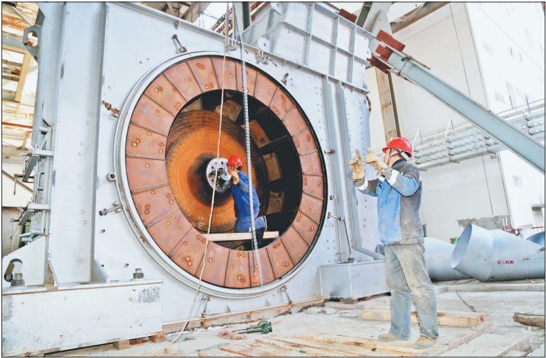
神华国能宝清煤电项目现场工人们正在安装磨煤机。
