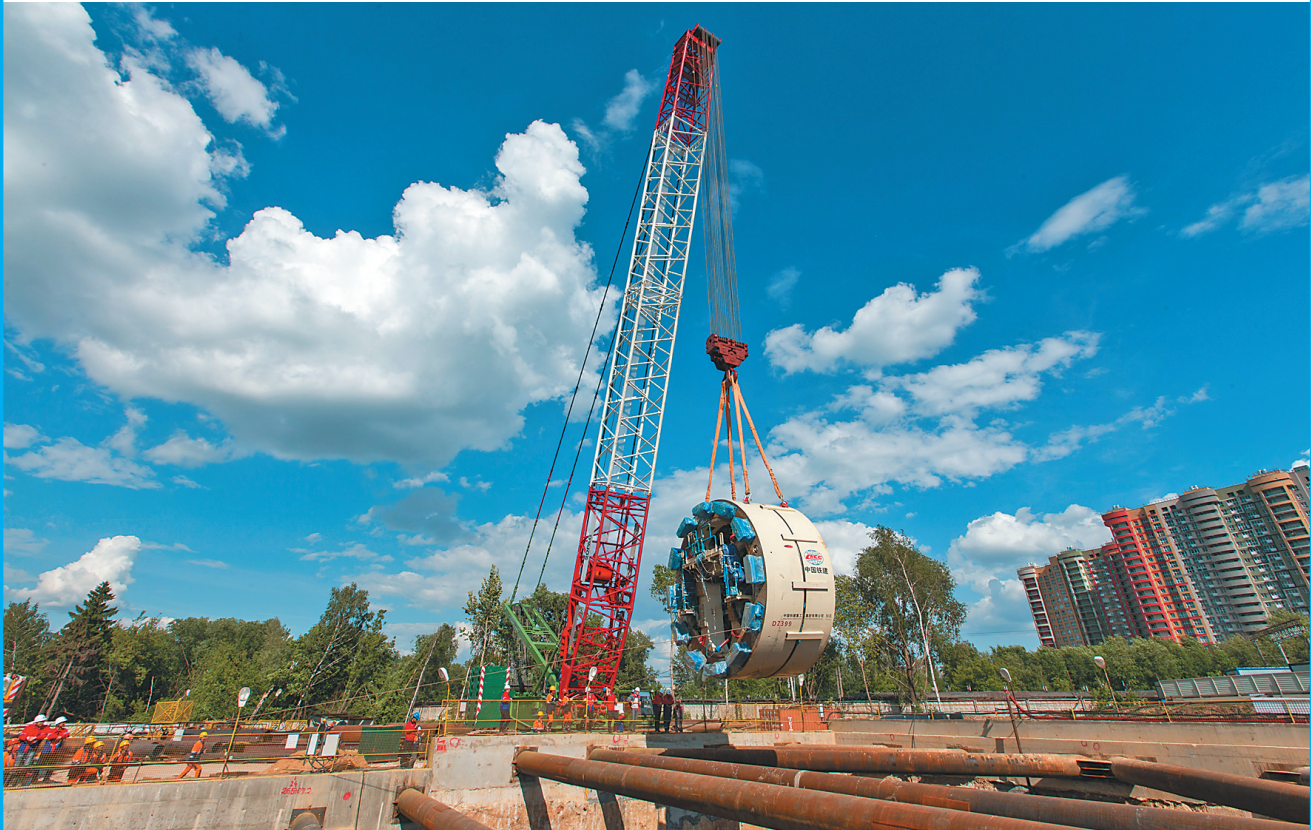
6月3日,在俄罗斯首都莫斯科,起重机吊装盾构机核心部件。中国铁建股份有限公司(中国铁建)3日在莫斯科西南部成功吊装第三台盾构机核心部件,为本月中旬开始掘进地铁隧道做好准备,标志着该公司承建的莫斯科地铁项目建设顺利推进。
