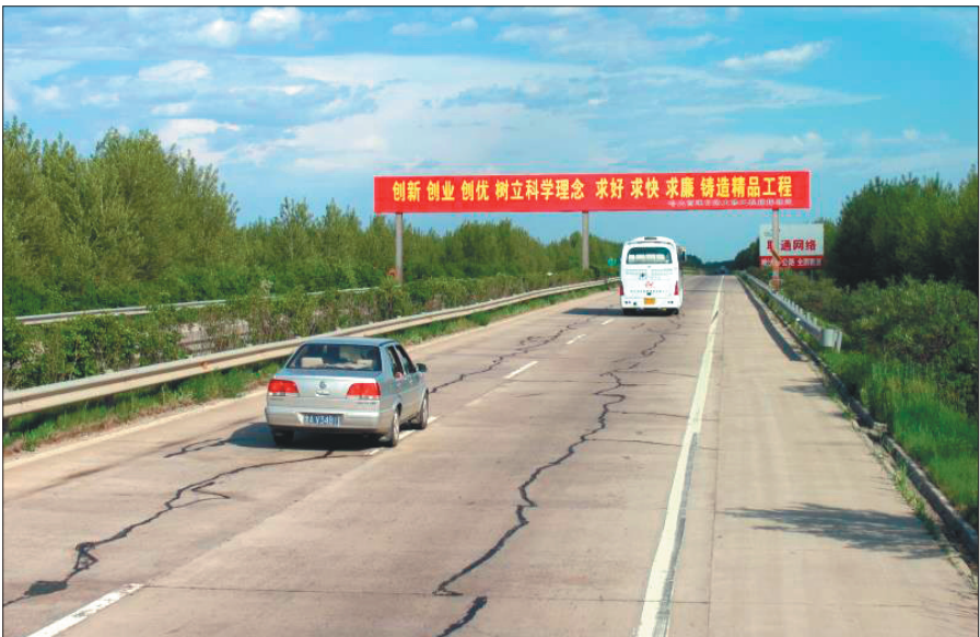
2003年,受当时技术工艺限制,哈大高速的路面已经出现斑駁裂缝。 姜久明摄
