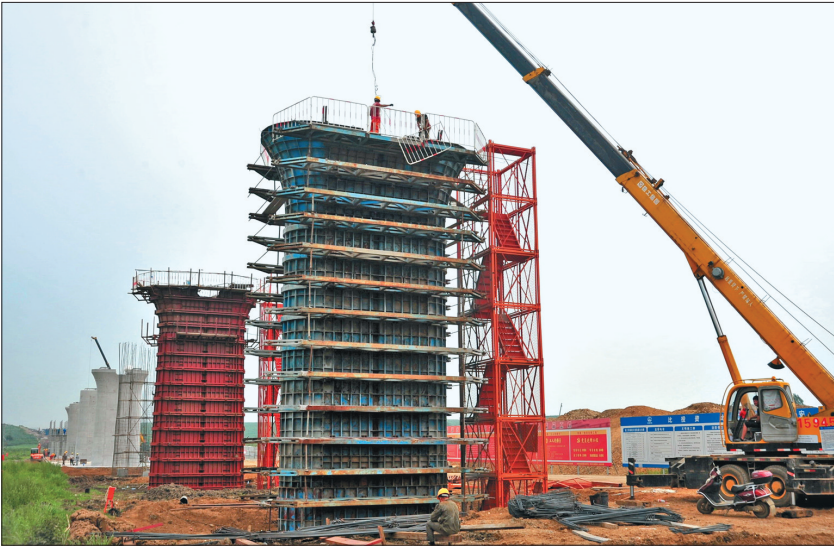
牡佳客专一标段的亮子河特大桥位于北山村,特大桥全长2131米。截至目前,桩基已全部完成698根,承台完成66个。亮子河特大桥工程现场建设者们正在加紧施工。
