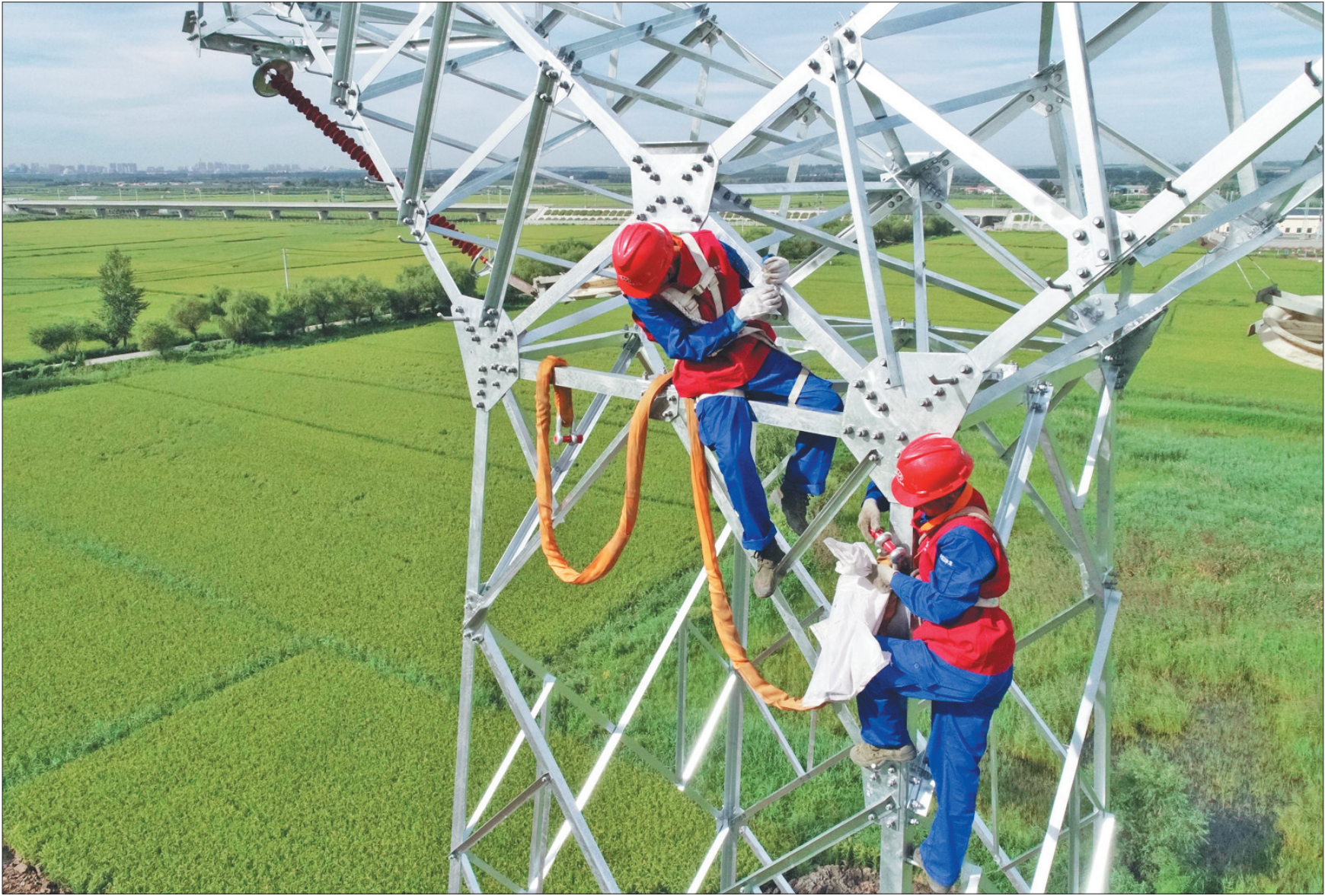
哈牡阿城北牵引站外部供电工程现场作业人员进行组塔施工。 省电力公司提供
