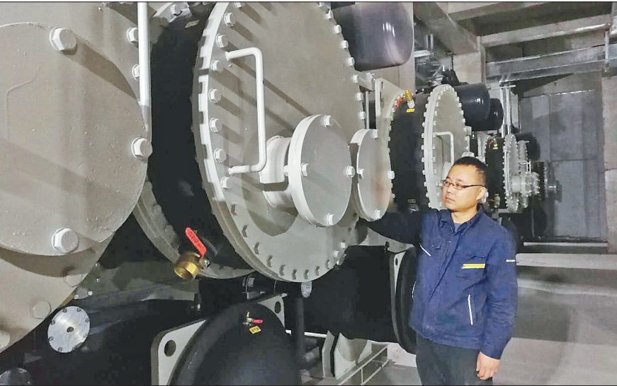
技术人员在巡检污水源热泵锅炉。
