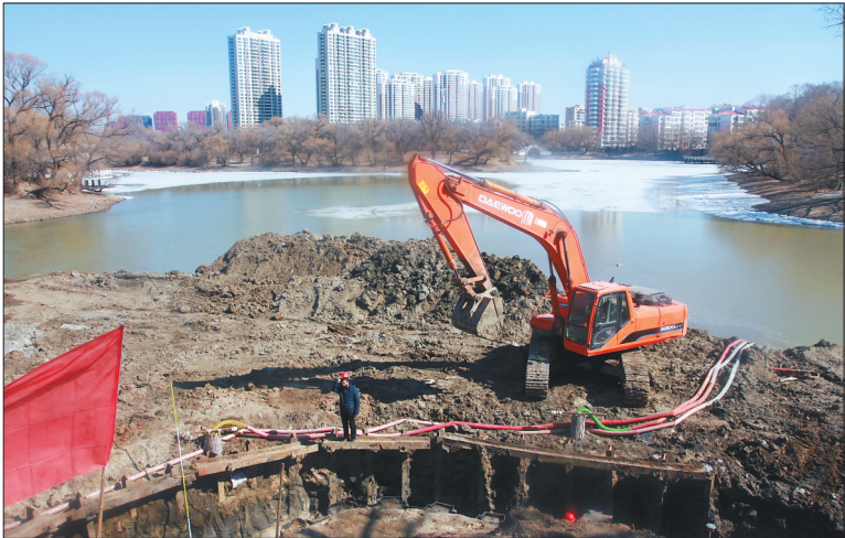
近日,劳动湖水生态恢复与嫩江连通工程全面进入基础开挖阶段。工程通过进水船闸引渠疏浚、清淤湖底、加固湖岸、新建淤压坝、涵洞等工程措施,实现劳动湖水体自身流动,生态环境将得到极大改善。
