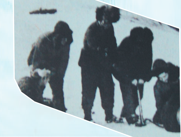
↑机务人员改装适合使用酒精的发动机喷嘴。 ↓轮流奋战,用自行车气筒给飞机轮胎打气。
