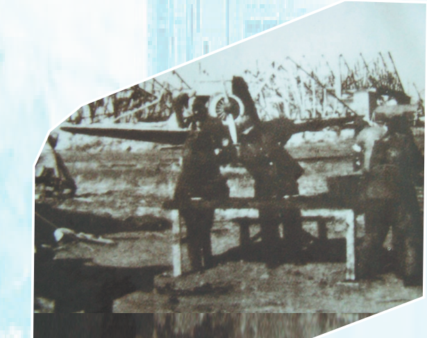
↑机务人员改装适合使用酒精的发动机喷嘴。 ↓轮流奋战,用自行车气筒给飞机轮胎打气。
