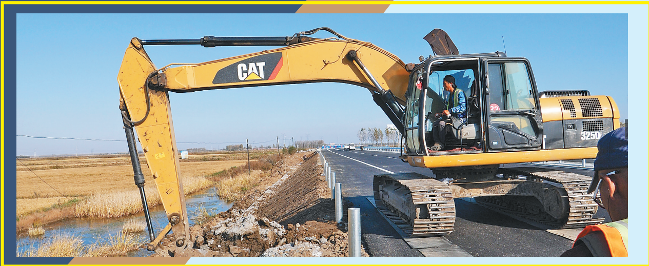
国道京抚公路汤原至佳木斯段改扩建工程路肩、边坡整形施工。
