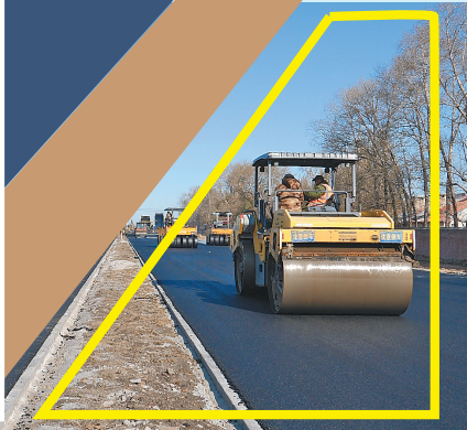
国道同哈公路万发至沿江段改扩建工程沥青混凝土路面碾压施工。
