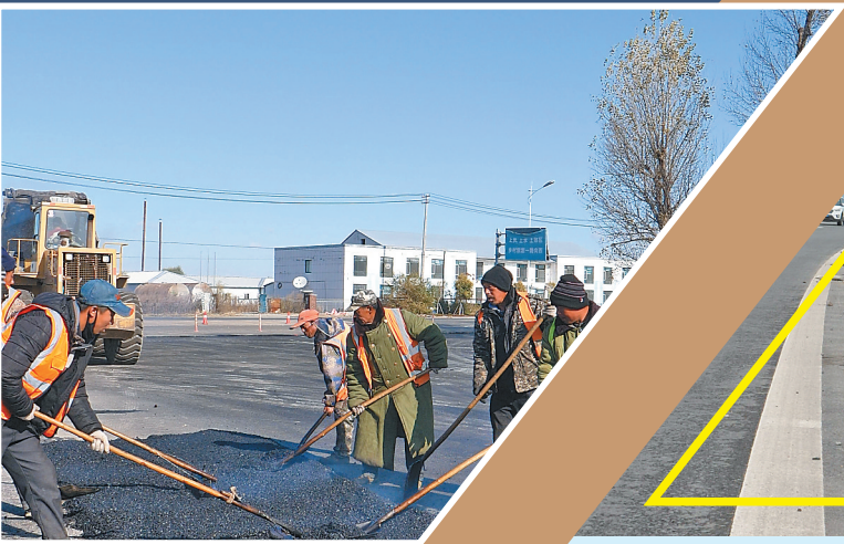
国道同哈公路万发至沿江段改扩建工程人工摊铺沥青路面施工。
