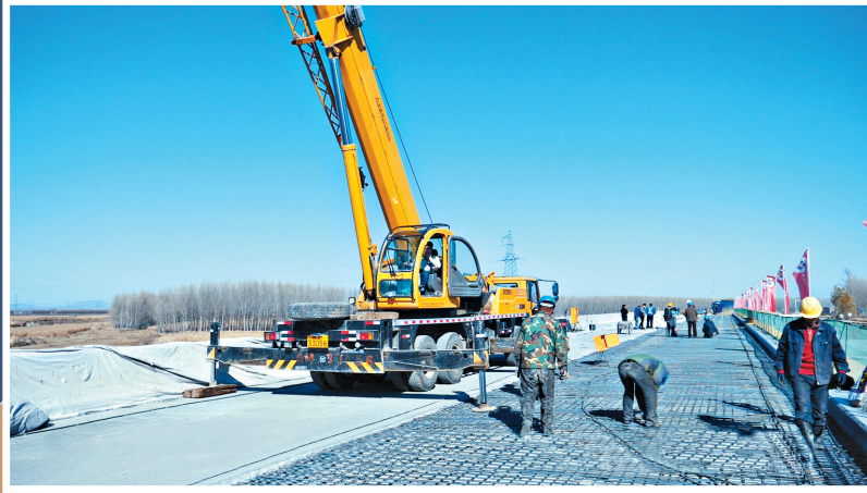
国道京抚公路汤原至佳木斯段改扩建工程裕河大桥桥面铺装施工。
