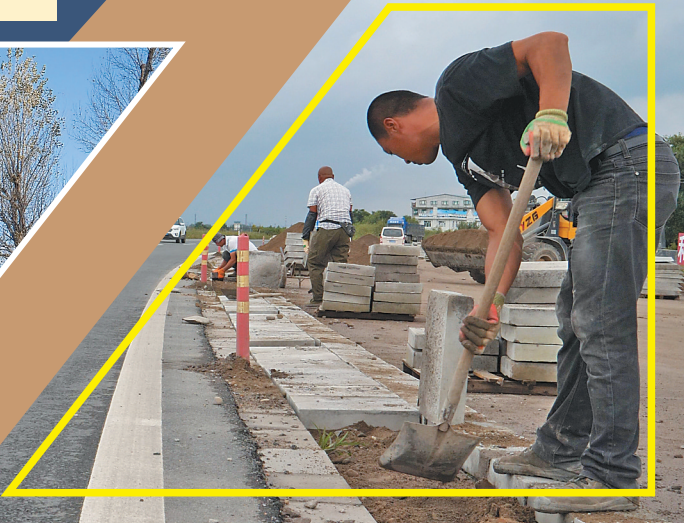
国道京抚公路佳木斯至桦川段改扩建工程中央隔离带预制块施工。
