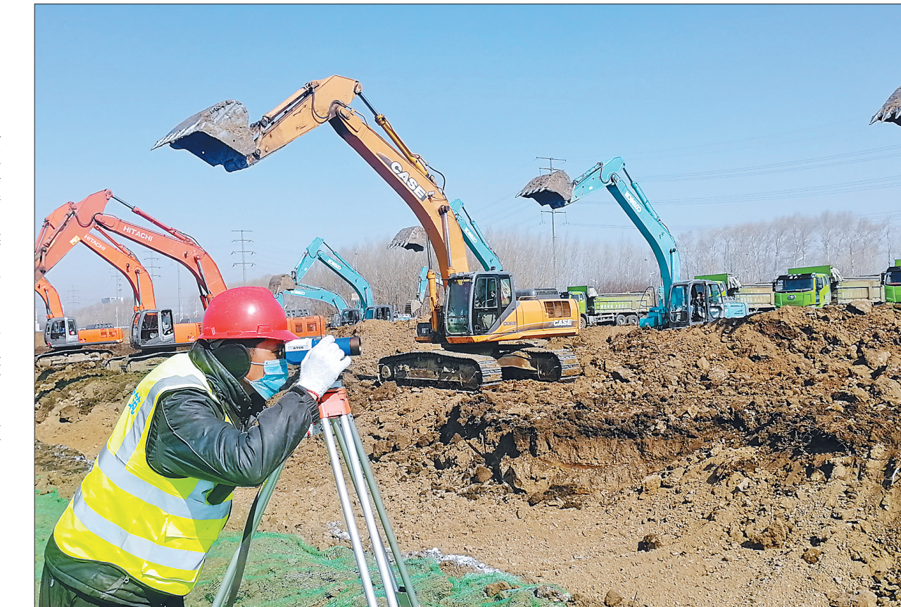
哈尔滨中俄国际农产品交易中心项目建设开工现场。
