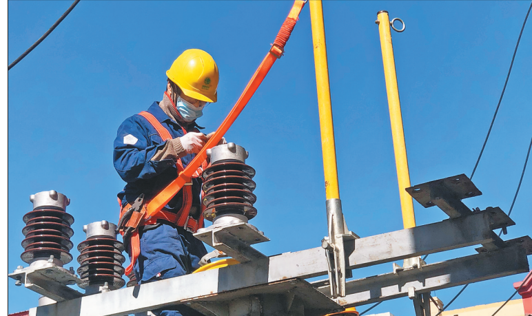
日前,由国网哈尔滨供电公司负责的珠江66千伏变电站2号主变压器增容改造工程顺利投产,为疫情期间哈尔滨市首个竣工电网改造工程。该工程的建成投产,优化了香坊区66千伏电力网络,大幅提升了珠江变电站的供电可靠性,有效缓解了珠江路、莱艺街周边地区的供电压力。 本报记者 刘艳摄
