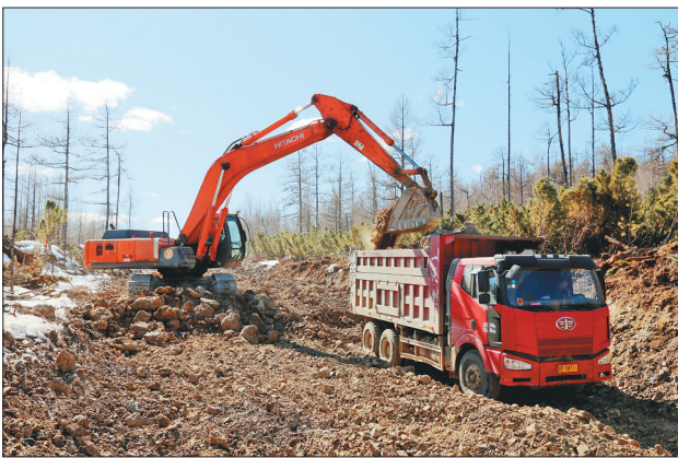
呼中区林呼公路至小白山公路建设项目现场。
