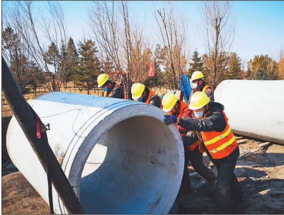
加格达奇区“三供一业”供水项目和经开区取水供水工程项目有序施工。
