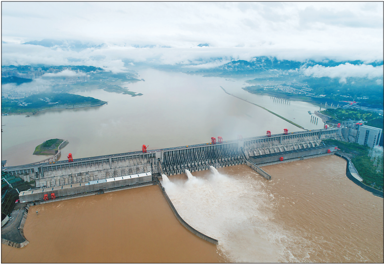
长江三峡枢纽开启泄洪深孔泄洪(7月2日摄,无人机照片)。 受强降雨影响,长江上游干流、乌江及三峡区间来水明显增加,2日10时三峡水库入库流量达50000立方米/秒。根据全国主要江河洪水编号规定,此次来水达到洪水编号标准,“长江2020年第1号洪水”在长江上游形成。
