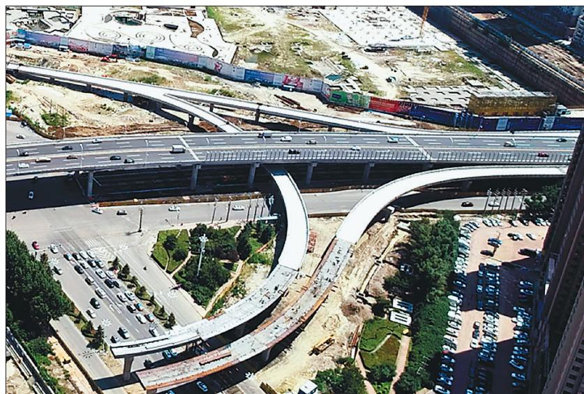
日前,哈尔滨东二环高架桥长江路互通桥钢箱梁吊装成功,东二环高架施工进入快速推进阶段。工程整体计划9月末通车。
